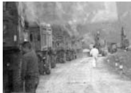
道路・河川等のインフラ復旧工事
