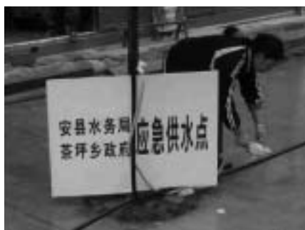
茶坪の仮設上水道
